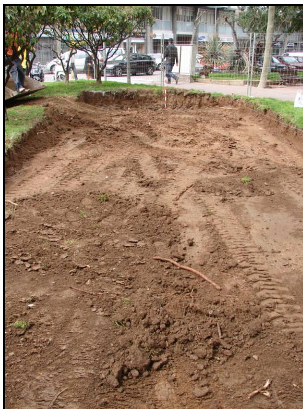
Figura 10. Foto cap al nord del final de les tasques de rebaix.
